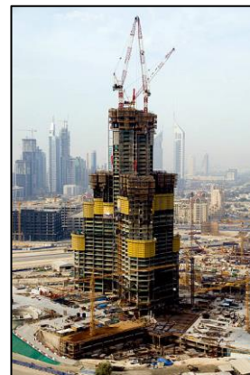
Phase de construction de la tour
