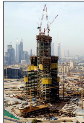
Phase de construction de la tour
