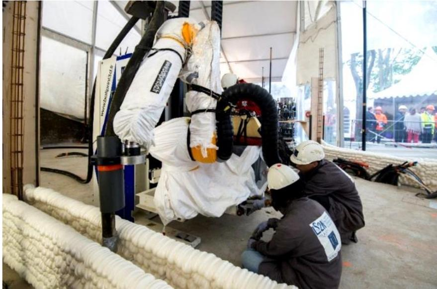
Figure 4 - Robot en phase d'impression du mur.
